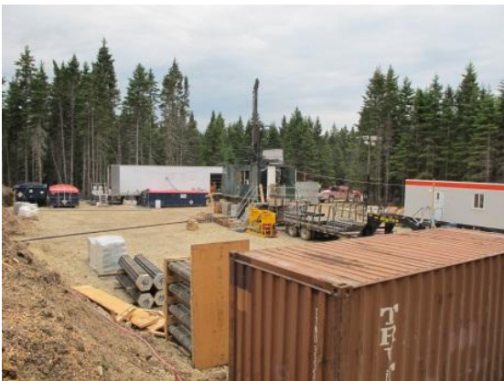
Figure 6. Photo d'un site pendant les travaux
